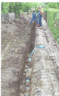
Die ca. 50 Jahre alte Wasserleitung war an vielen Stellen durchgerostet und musste 2020 erneuert werden. Danach wurden die Gartenwege wieder instandgesetzt.
