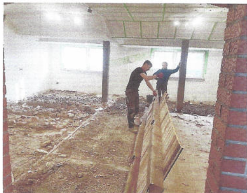
Bei der Erneuerung des Fußbodens im Gastraum machte das Vereinsheim keinen einladenden Eindruck.
