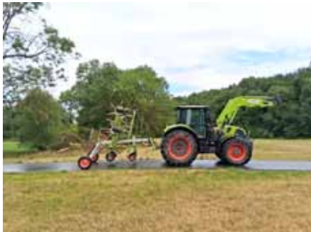
Ausbau ländlicher Weg bei Neusiß (Foto: TMWLLR)
