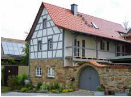
Sanierter Fachwerkhof in Hainbücht, Saale-Holzland-Kreis (Foto: TLLLR)
