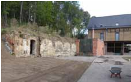
Brachflächenrevitalisierung Neustadt an der Orla, Ortsteil Modersdorf (Foto: TLLLR)
